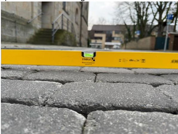
c) Fahrbahnsenkung
