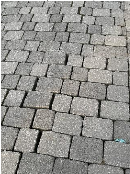
c) Fahrbahnsenkung
